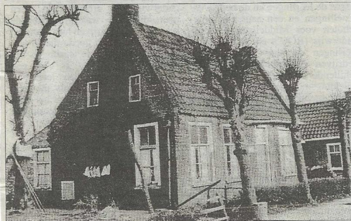
Twee foto's van het huis Augustinusga 105 dat eens toebehoorde aan Johan Diederik van Nimwegen en Jeltje Posthuma. In 1968 gesloopt, maar hiervoor van gemeentewege gefotografeerd. Gebouwd vermoedelijk in de tweede helft van de 18de eeuw. De muren waren gemetseld van gele baksteentjes. De twee raampjes in de linker zijgevel lijken nog authentiek, evenals de schoorstenen en het dak. Waarschijnlijk zijn de ramen in latere jaren door een verbouwing groter gemaakt. In 1980 is op de plek een nieuw huis gebouwd. Het adres is nu Sylgong 5 te Augustinusga. Evenals voor de oude woning, staan er nu ook weer linden geplant.
